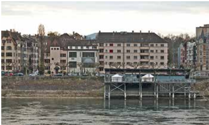
Das Rheinbad Breite im heutigen Zustand – Winteraufnahme mit den Jurten des Saunabetriebs. Foto: Miller & Maranta AG
